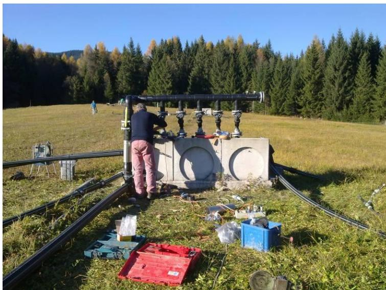
Foto 13: intervento di manutenzione dell'impianto di estrazione del biogas
