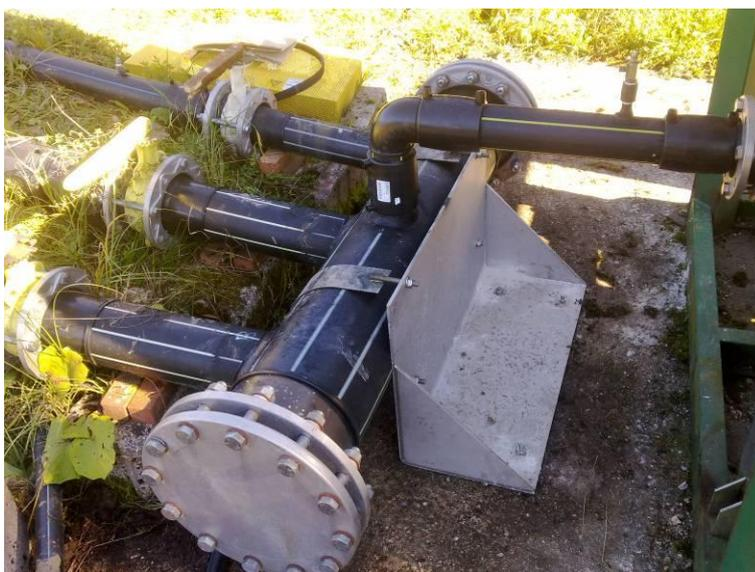
Foto 12: fissaggio del collettore di raccolta del biogas
