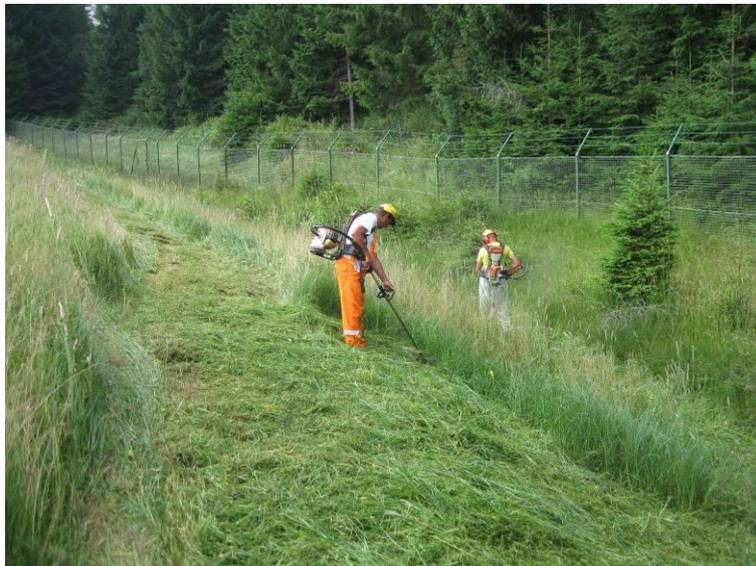
Foto 4: operazione di sfalcio manuale sulle scarpate
