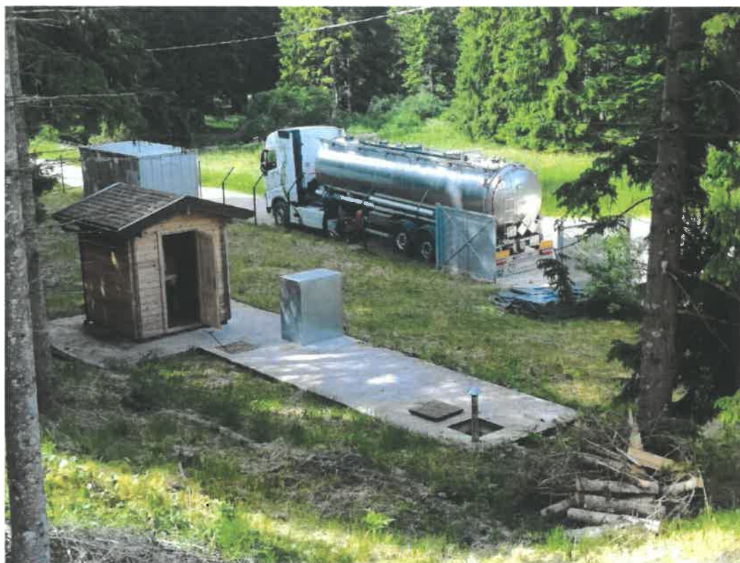
Foto 15: prelievo del percolato dalla vasca di raccolta
