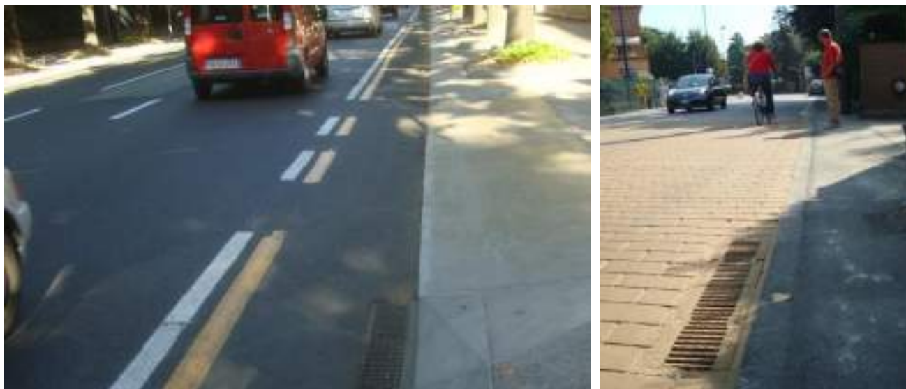
Figura 443 Esempio di interventi pericolosi: Caditoie su corsia ciclabile
