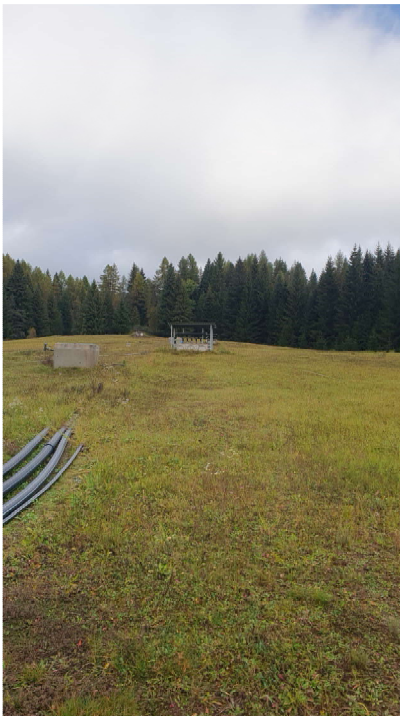
Foto 10: la discarica vista da sud - ottobre
