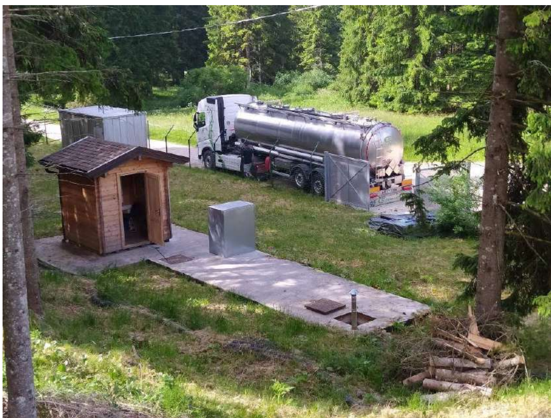
Foto 15: prelievo del percolato dalla vasca di raccolta
