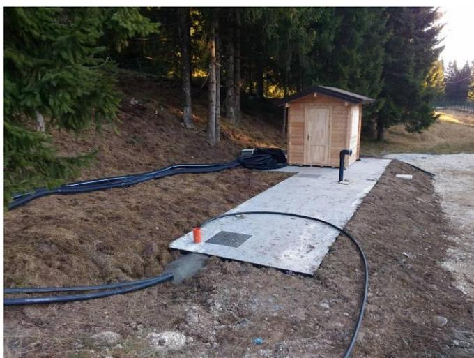
Foto 12: la nuova vasca di raccolta interrata ed il locale di controllo
