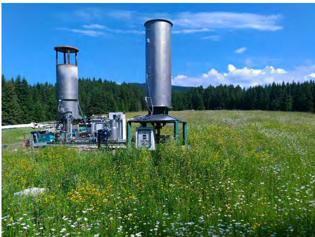
Foto 14: la nuova centrale di combustione del biogas, posta nelle vicinanze della precedente
